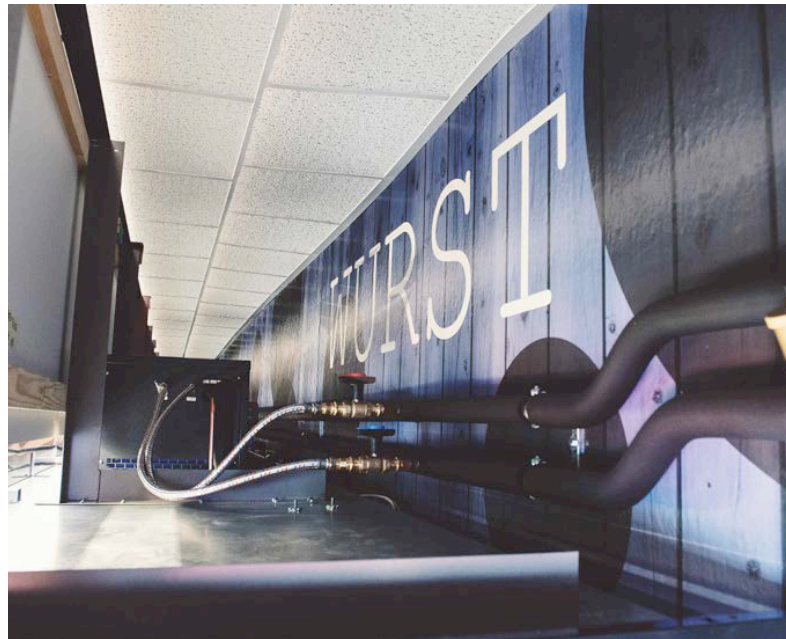
Die Ko-Mod-Boxen werden in den NP-Märkten direkt auf den Wandkühlregalen montiert und ermöglichen eine individuelle Kühlung der einzelnen Kühleinheiten.
