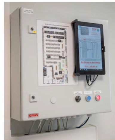
Alle klimarelevanten Funktionen werden bei NP über das zentrale Kontroll- und Steuerungssystem geregelt
