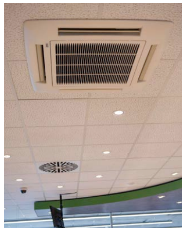
Wärmetauscher im Markt: Klimatisieren im Sommer, Wärmerückgewinnung zum Heizen im Winter mit dem Kälte-Hybridsystem.
